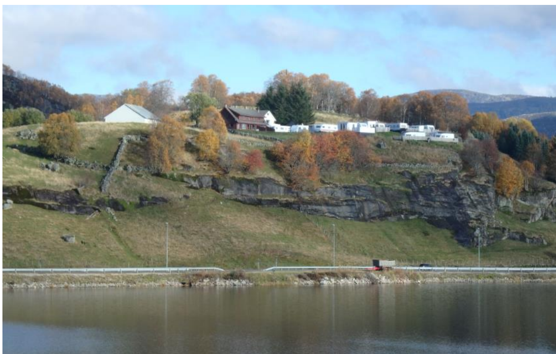
Figur 3.2 Planområdet med eksisterende bebyggelse og campingvognoppstilling zoomet noe inn fra samme ståsted som bildet i figur 3.1.
