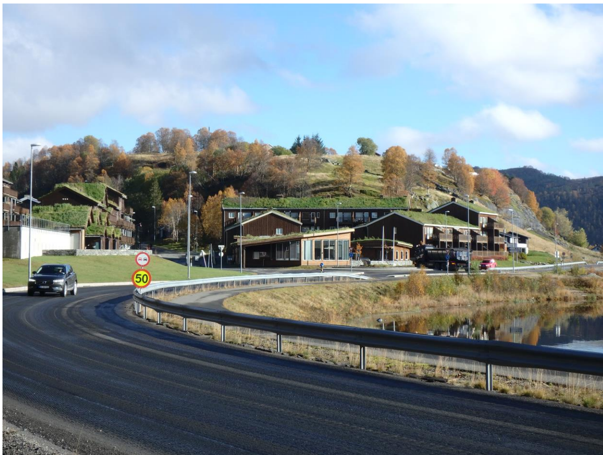
Figur 3.3 Innsyn mot planområdet fra fylkesveien vest for rundkjøring / avkjørsel.
